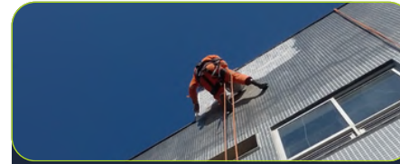
Reforma de Fachada
